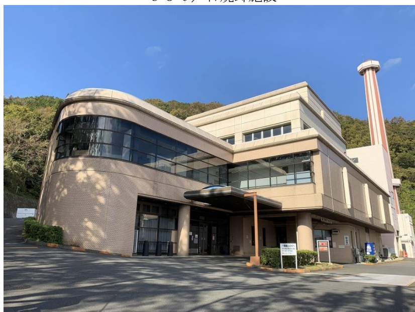
90t/日焼却施設
